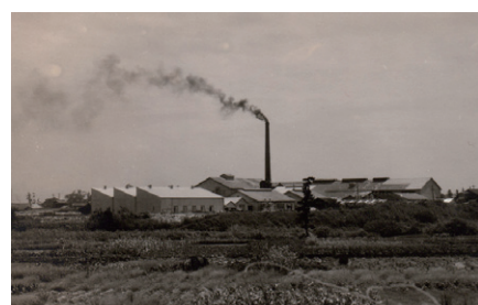
1959年に完成したメラミン化粧板製造工場
